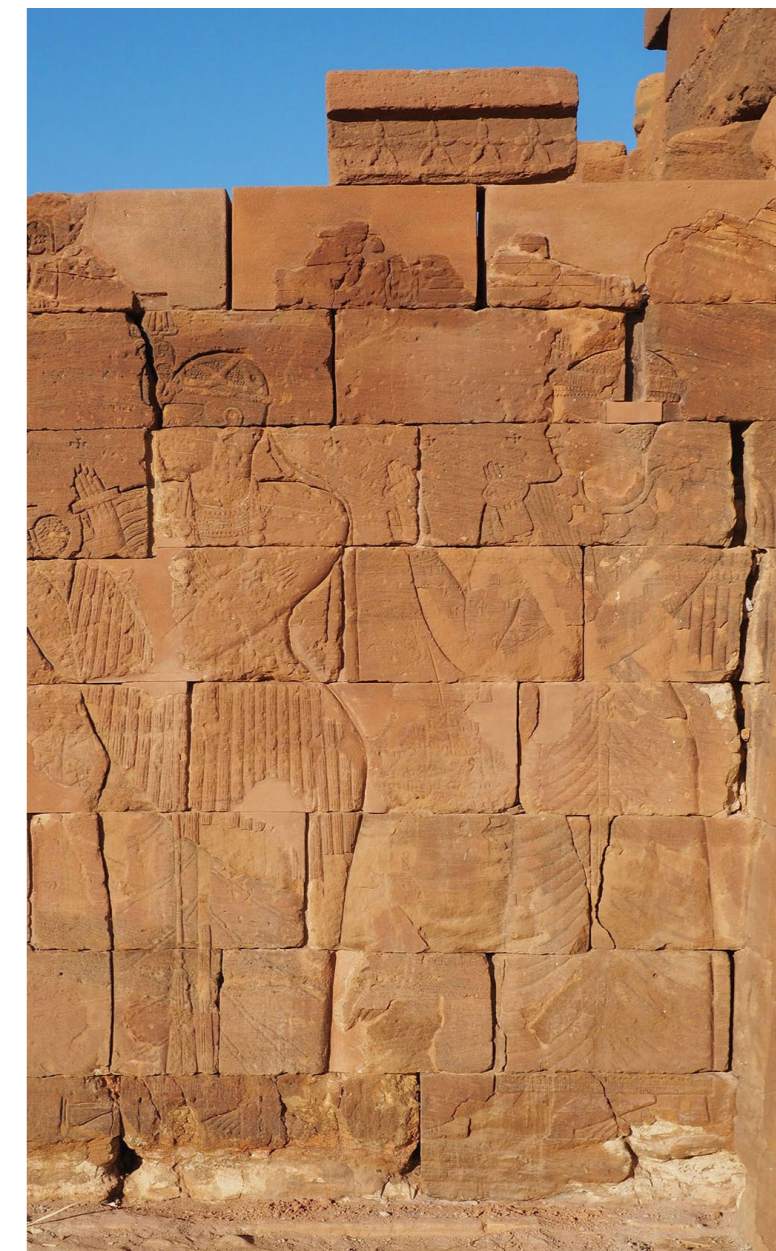
Abb. 8: Teil der äußeren Südwand des Löwentempels nach der Restaurierung, © Naga-Projekt.
