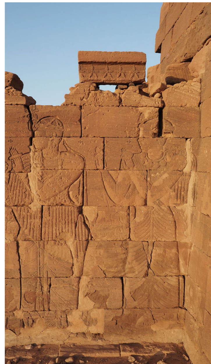
Abb. 7: Teil der äußeren Südwand des Löwentempels vor der Restaurierung, © Naga-Projekt.
