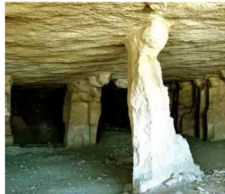
Abb. 2: Galeriesteinbrüche im Wadi Nakhla/Mittelägypten. Einer bestimmten, qualitätsvollen Schicht im Kalksteingebirge wurde unter Tage das Gestein abgebaut. Im Inneren wurden Stützpfiler belassen. Es gibt Beispiele, wo trotz solcher Pfeiler die Decke dennoch eingebrochen ist.
