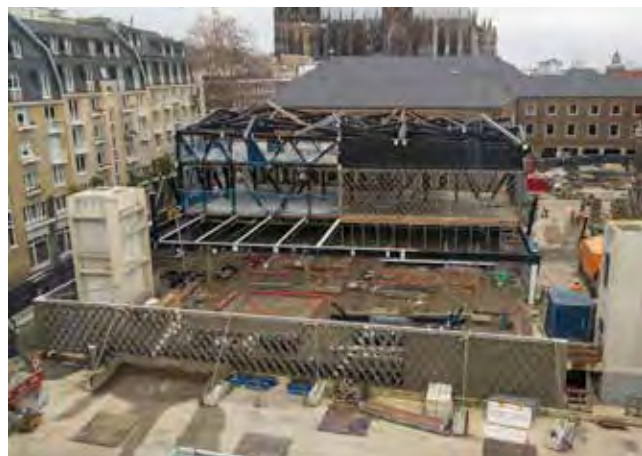
Abb. 1: Baustelle MiQua (Dez. 21) © Jasmin Anilgan/LVR.
